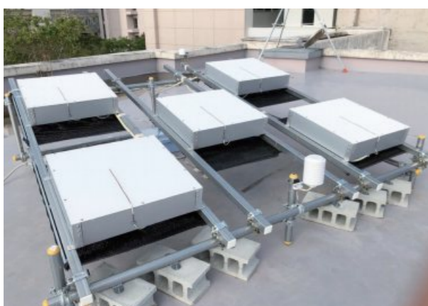
遮熱塗料の暴露試験
